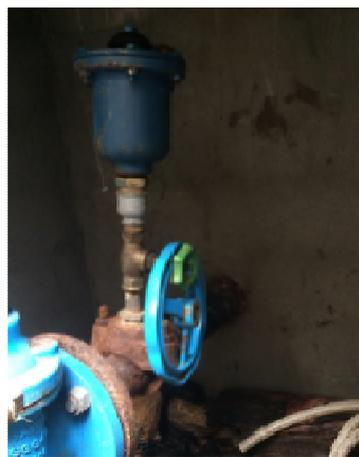
Foto 19: Valvola di riduzione tipo Hawle DN 65
