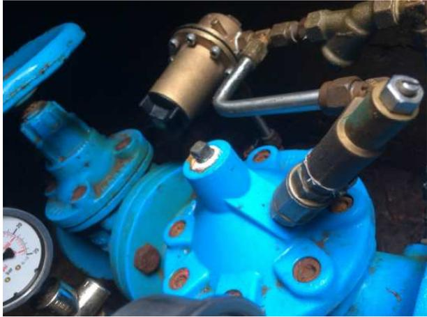
Foto 16: Valvola di riduzione tipo Hawle, DN 65 mm (vecchio modello)
