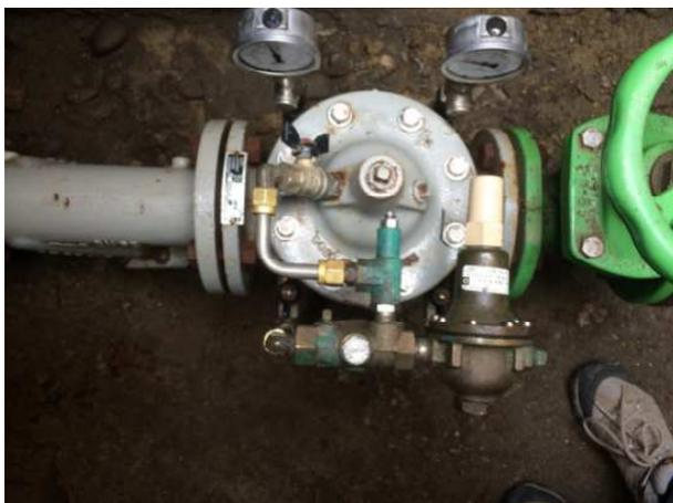
Foto 11: Valvola di riduzione tipo Claval DN 65 mm
