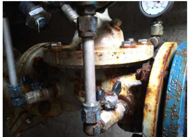
Foto 6: Valvola di riduzione tipo Claval DN 65
