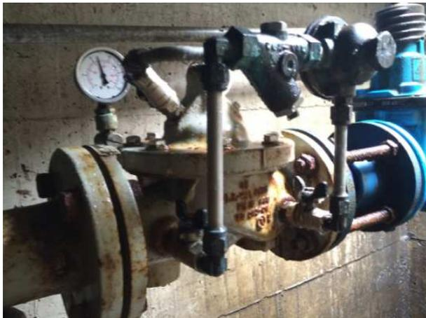
Foto 5: Valvola di riduzione tipo Claval DN 65 mm
