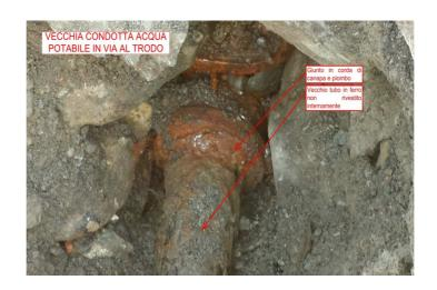
La nuova condotta sarà posata parallelamente alla vecchia; il vecchio idrante sottosuolo sarà sostituito con un nuovo modello a colonna.
