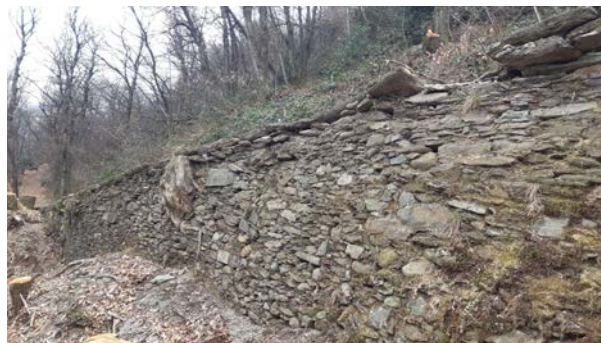
Foto 3. Muro di sostegno. A. Pirrami.
