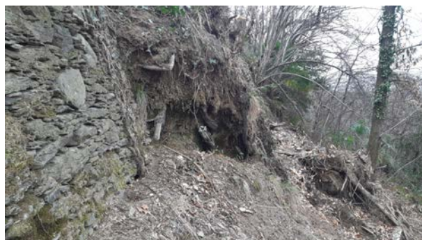
Foto 6. Dettaglio delle ceppaie incastonate del muro. A. Pirrami.
