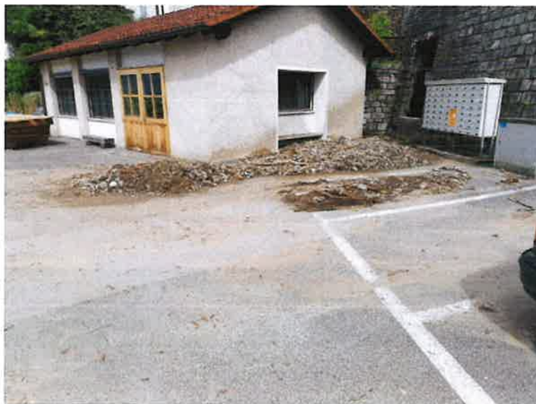
Figura 2. Fuoriuscita di materiale sulla strada pubblica e nel parcheggio della chiesa di S.ta Maria Nascente (evento del 13.07.2021).
