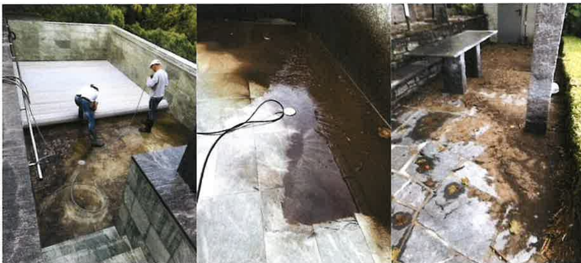
Figura 3. Invasione della piscina e del pergolato del mappale privato n. 334 RFD Gambarogno da parte della portata mista, fuoriuscita dal riale CAV-007 nel corso dell'evento notevole del 29.08.2021.
