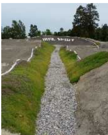
Figura 14: Esempio e concetto (linee blu e celesti) di trincea drenante tra i rettilinei
