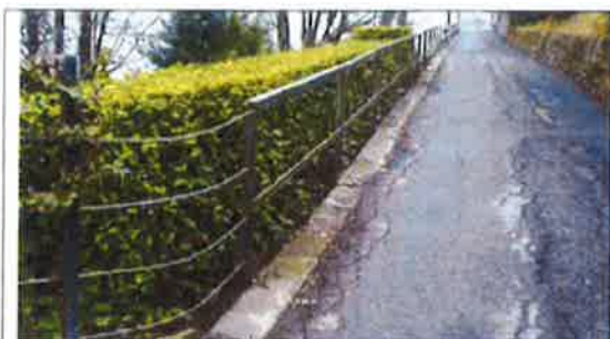
Vista del tratto di strada da ovest verso est
