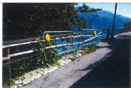
Sbarramenti e segnaletica provvisoria
