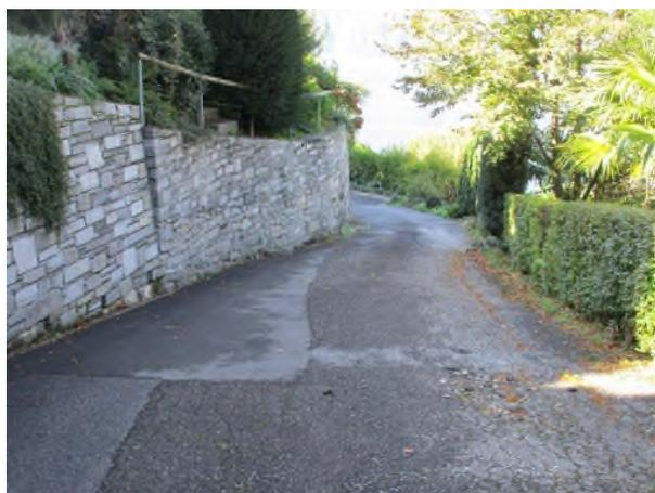
Foto 5: Pavimentazione in cattivo stato
